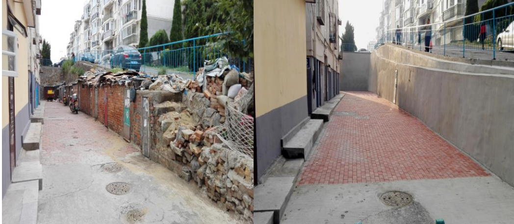
春光街 26 号楼院改造前后图片
