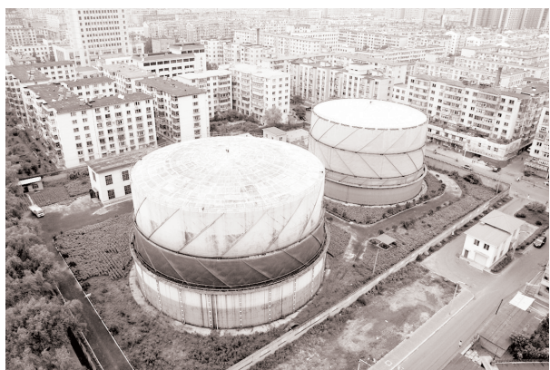
储罐（左为 1 号罐、右为 3 号罐）
