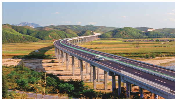
沈丹高速公路四台子特大桥
