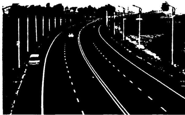
西土线改扩建工程全线竣工通车
