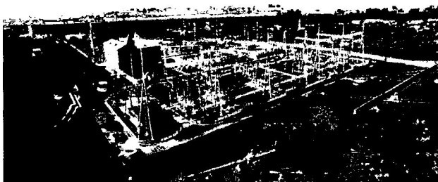
首山 220 千伏变电站改造工程顺利投运
