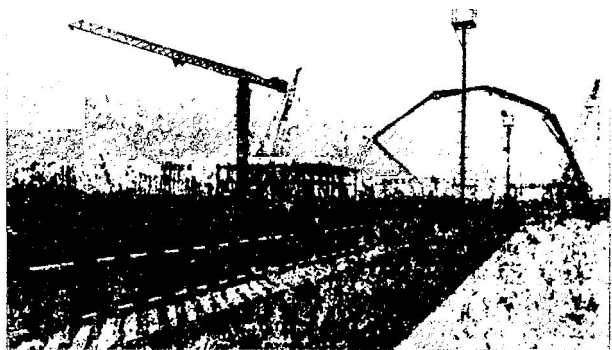
国外工程施工现场
