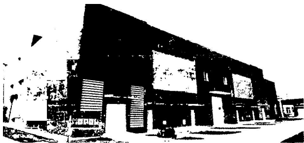
辽阳首座220千伏户内式变电站顺利投运
