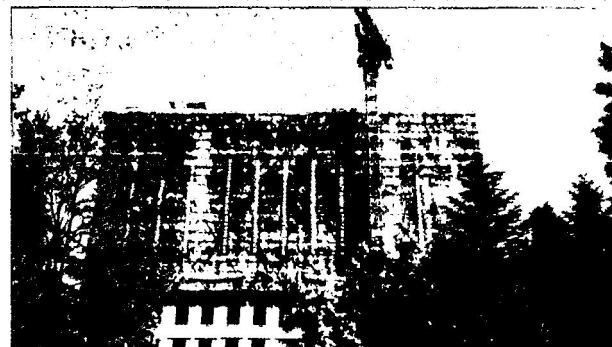
辽阳九院幸福辽阳项目建设大楼封顶
